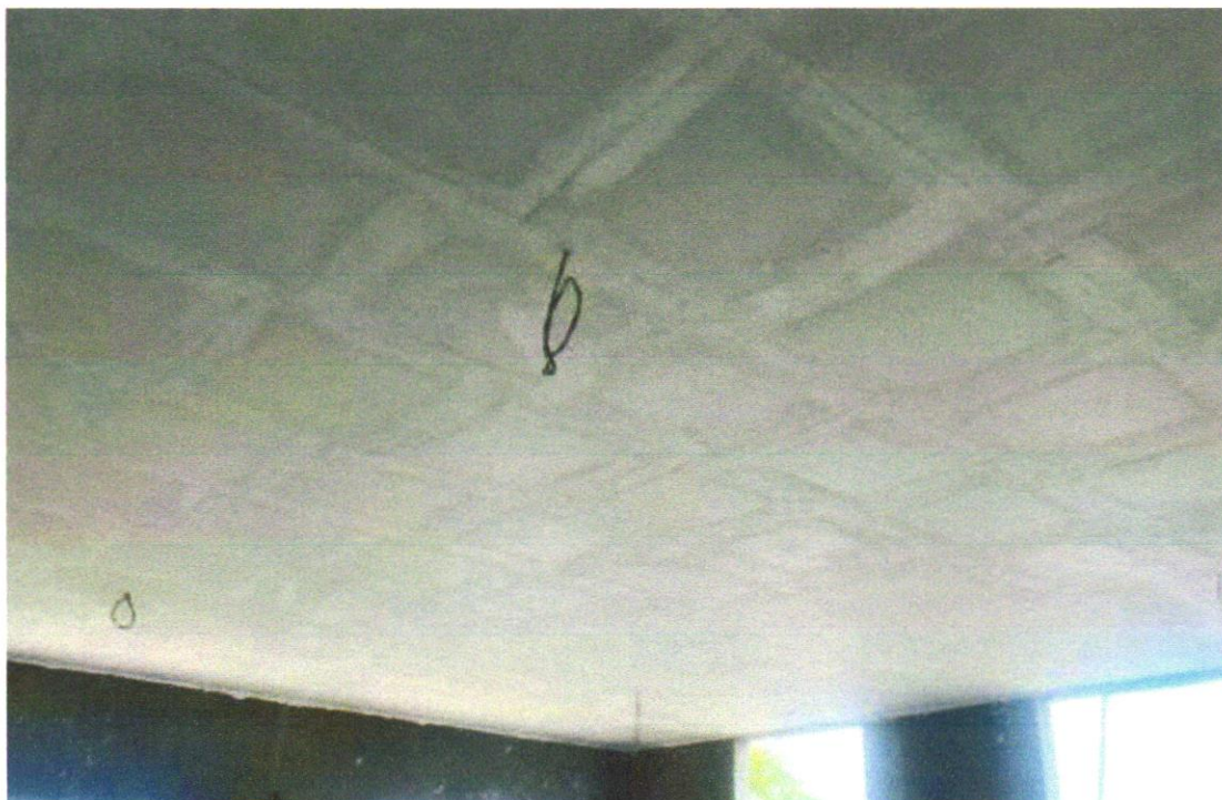
EXECUÇÃO DE FORRO DE GESSO.
