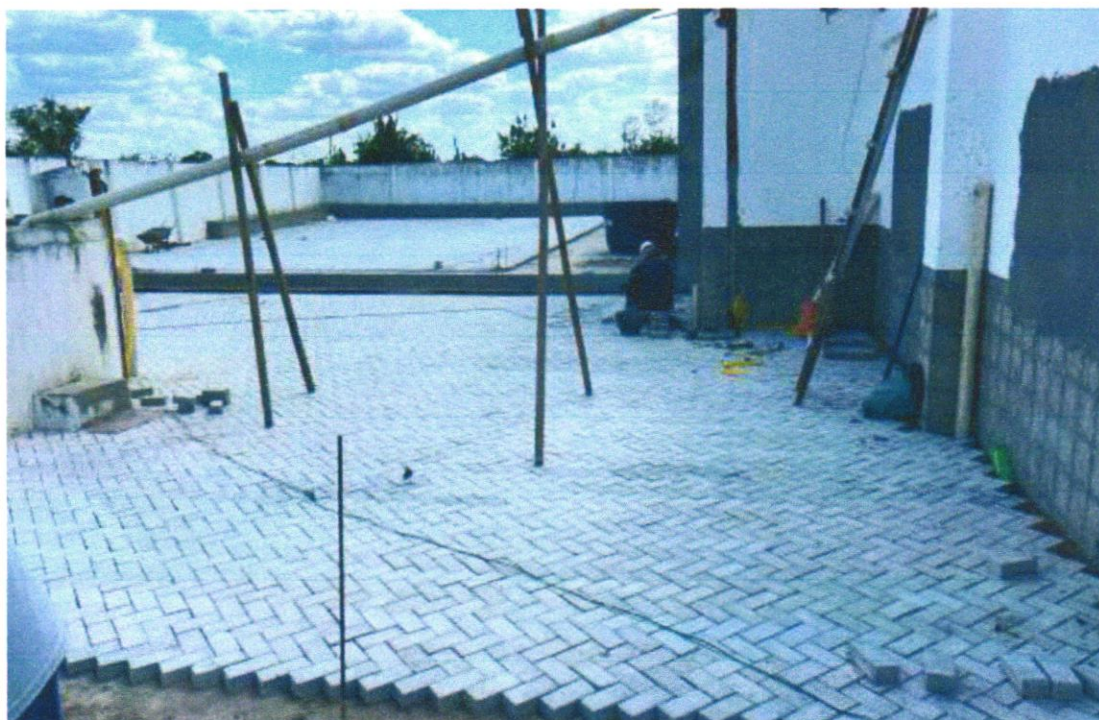
EXECUÇÃO DE PISO INTERTRAVADO.
