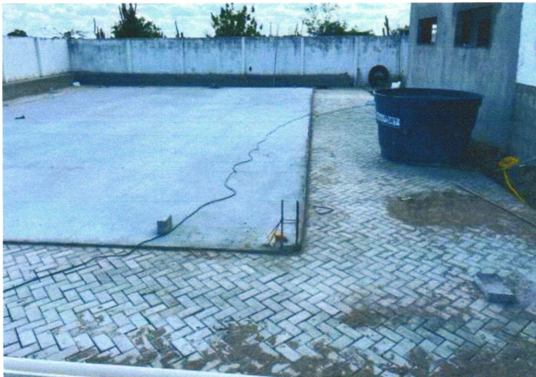
EXECUÇÃO DE PISO INTERTRAVADO.
