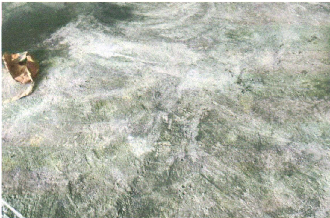
EXECUÇÃO DE PISO GRANILITE.
