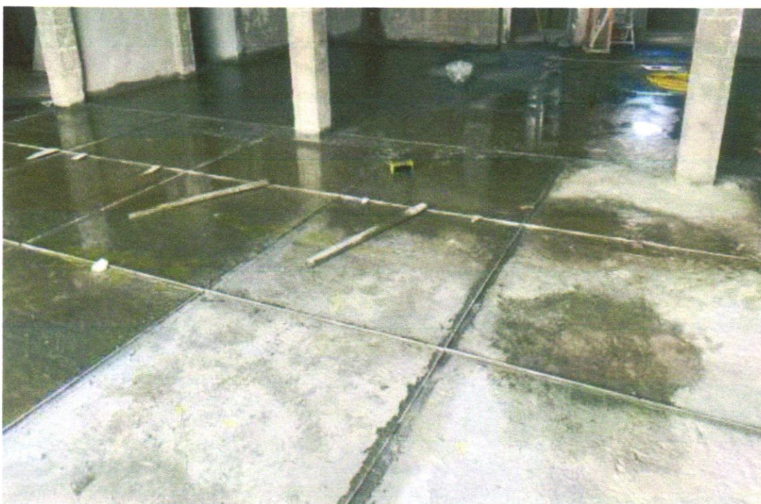
EXECUÇÃO DE PISO GRANILITE.
