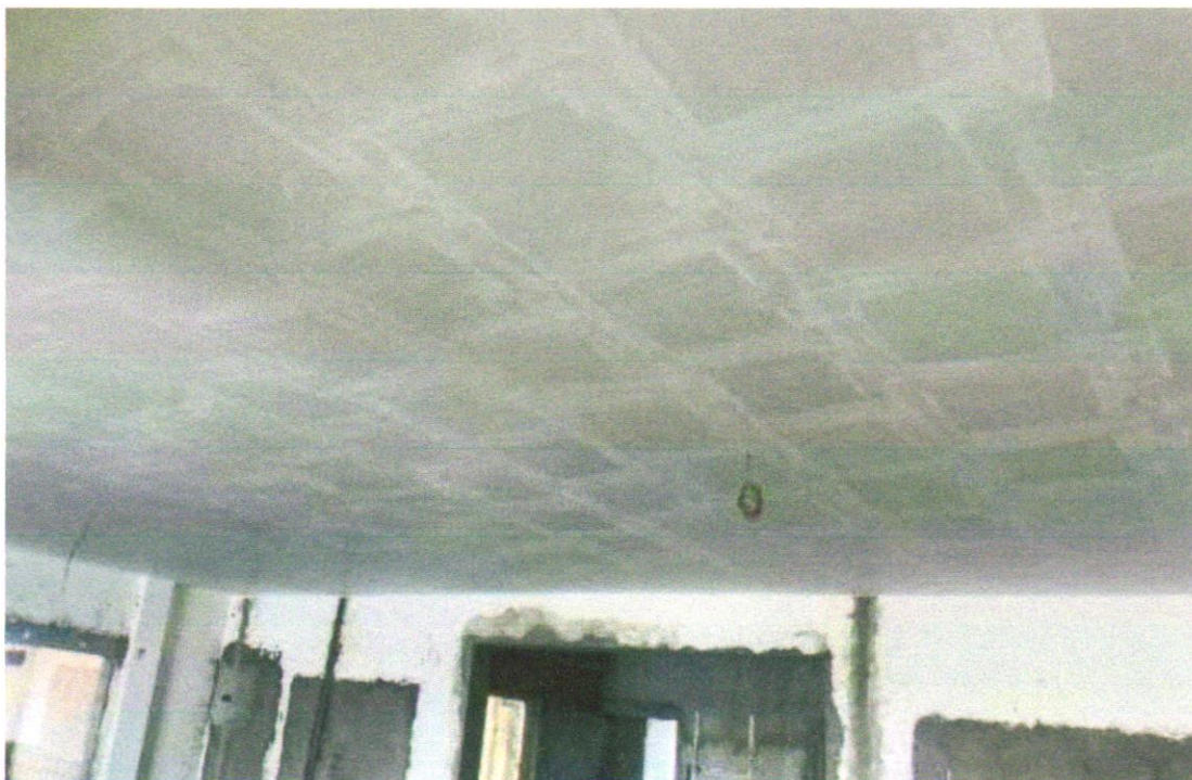
EXECUÇÃO DE FORRO DE GESSO.
